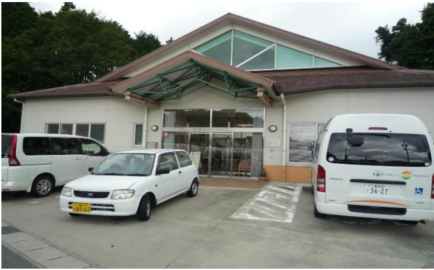
障害福祉サービス事業所 「青蓮寺オーラック」正面
