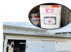
グラウンド 西倉庫内
