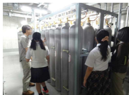
【消火用窒素のタンク】
