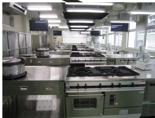
第一調理室（調理師養成施設実習室）
