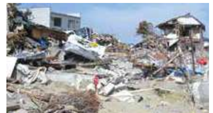
Zona de viviendas destruidas
