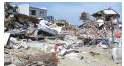
Conjunto residencial destruído
