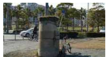
Bueiro expelido do buraco
