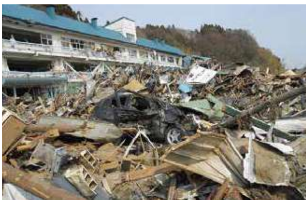
東日本大震災の被害
