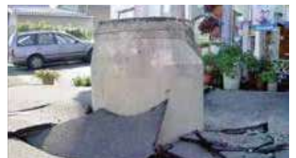
穿出地面的下水管道
