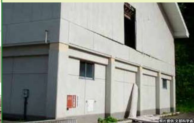
⑥ 外墙壁剥落
