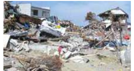
被破坏的住宅街区
