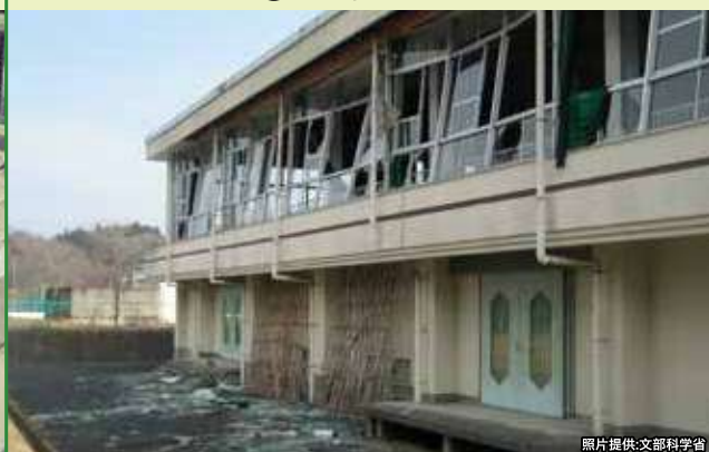
⑥ 外墙壁剥落
