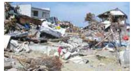
被破坏的住宅街区
