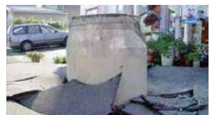
穿出地面的下水管道
