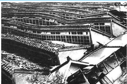
や ね とうかい あみかんせいもう こうじょう 屋根がうねるように倒壊した網勘製網の工場
