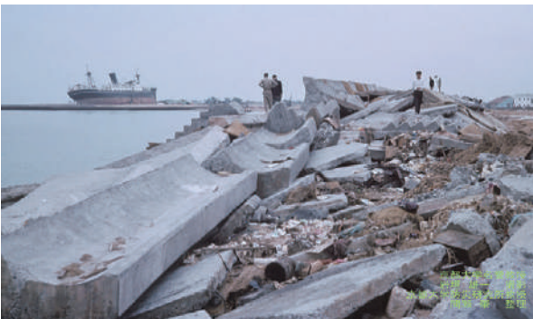
なみ さよう ていぼう いちぶ ごわ 波の作用でコンクリートでできた堤防の一部が壊れた
