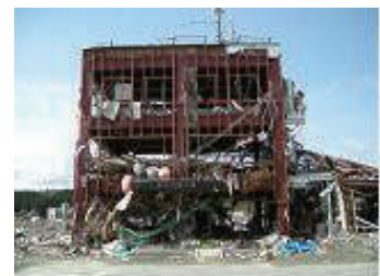
宮城県南三陸町防災対策庁舎
