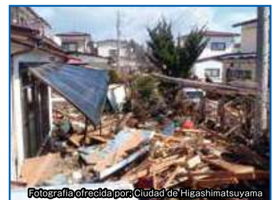
Fotografía ofrecida por: Ciudad de Higashimatsuyama
