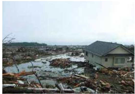
東日本大震災の被害
