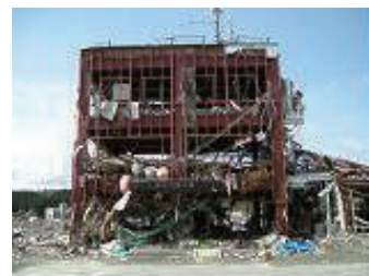
宮城県南三陸町防災対策庁舎
