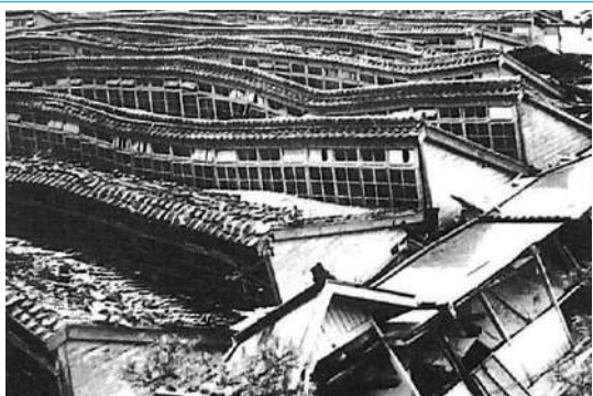
や ね とうかい あみかんせいもう こうじょう 屋根がうねるように倒壊した網勘製網の工場
