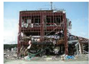
宮城県南三陸町防災対策庁舎
